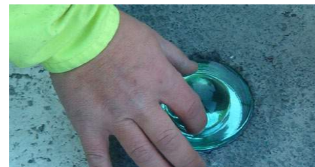
3. Colocación del captafaro
