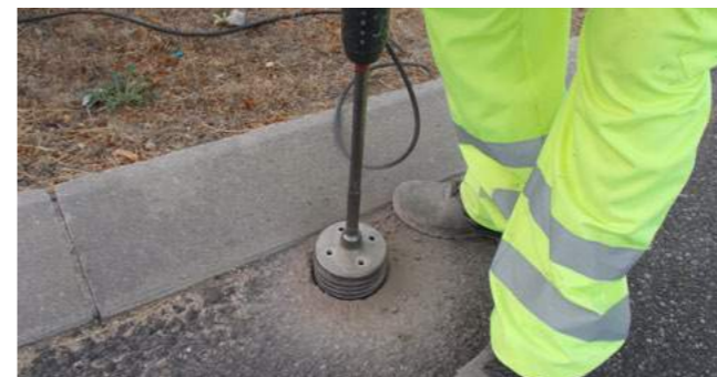
1. Agujereado del pavimento mediante corona
