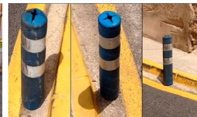
En las dos primeras imágenes se puede apreciar marcas de ruedas de vehículos pesados que han pasado por encima de las balizas. En la tercera imagen se puede apreciar que la baliza ha sido repetidamente golpeada. Tomadas el 26-7-2012.
