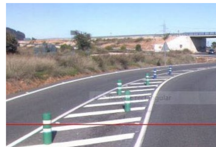
Situación antes del inicio de la prueba donde se puede apreciar la situación de dos balizas cilíndricas azules provisionales, al haber desaparecido las anteriores. Todas son de polietileno.
