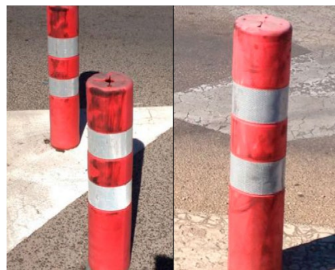
Imágenes tomadas el 6-11-2012 donde se puede apreciar que las nuevas balizas de EVA han sido golpeadas por los vehículos.
