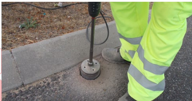
1. Agujereado del pavimento mediante corona
