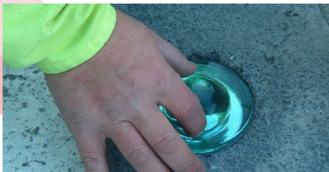
3. Colocación del captafaro
