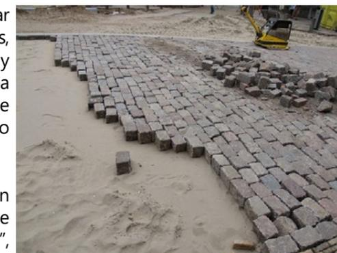
Tanto la compactación inicial como la compactación final, que se hace con el sellado de las juntas, se debe hacer con un vibrocompactador de placa o "ranita", de tamaño corriente, teniendo cuidado de no utilizar equipos muy grandes en pavimentos con adoquines de 6 cm de espesor porque pueden desfigurarlos.
