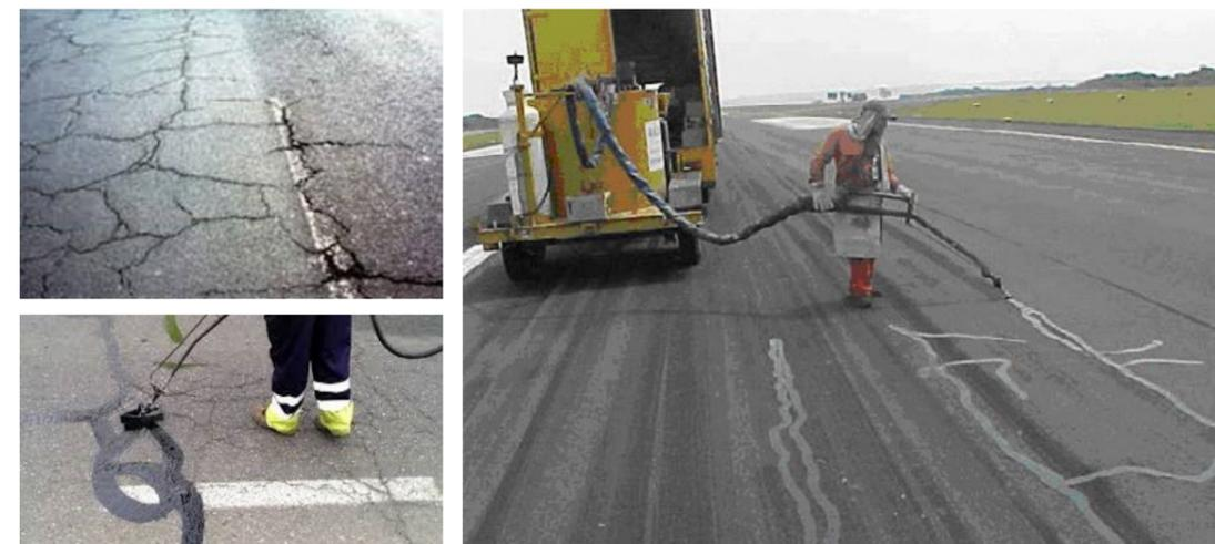
Seguidamente se procederá a llenar la fisura con material bituminoso con el objetivo de evitar su propagación y que la humedad llegue a las capas adyacentes de la estructura del pavimento, produciendo su deterioro así como también evitar la penetración de partículas extrañas utilizando para ello medios mecánicos.
