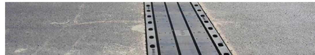
Las juntas elastoméricas son dispositivos diseñados para absorber los movimientos de las estructuras, dando continuidad a la banda de rodadura, consiguiendo por otro lado no ser una fuente de filtraciones a la propia estructura, ni una fuente de ruidos, vibraciones, ni impactos a los vehículos.
